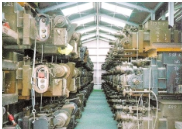
工場内のPCB含有機器 保管状況
