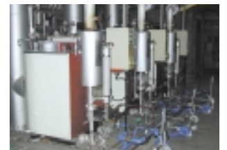
熱源の見直しにより大型ボイラーを省エネ型小型ボイラーに取替
