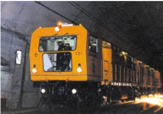
レール削正車によるレール削正
