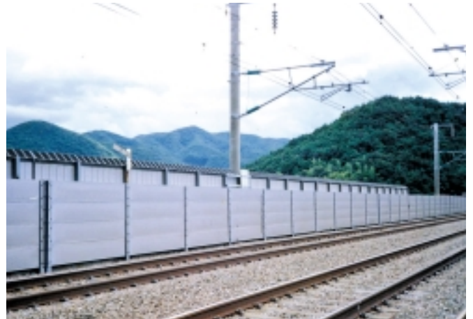
新幹線の干渉型防音壁と吸音板
